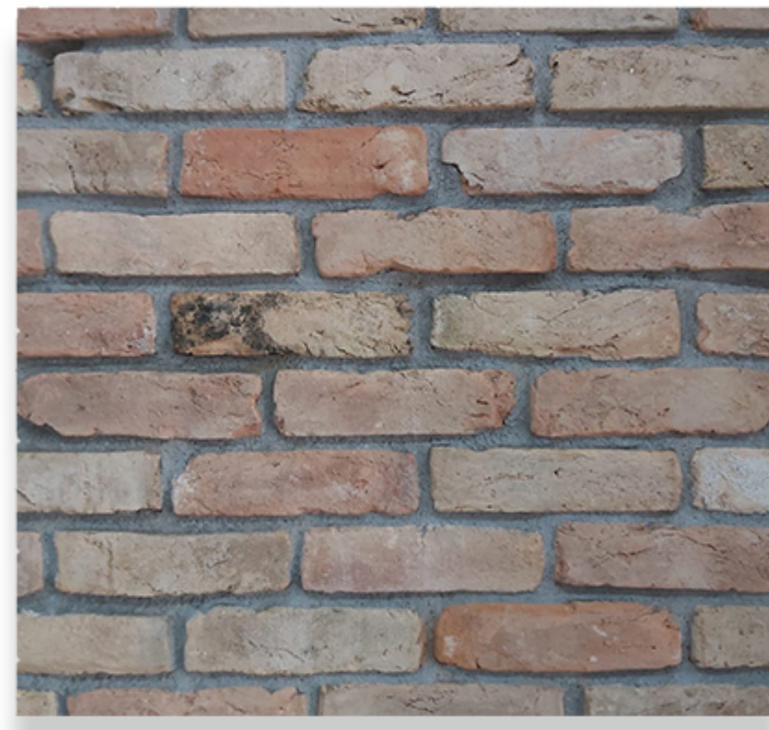
BMT0183 Harman Tuğla Söküm And
